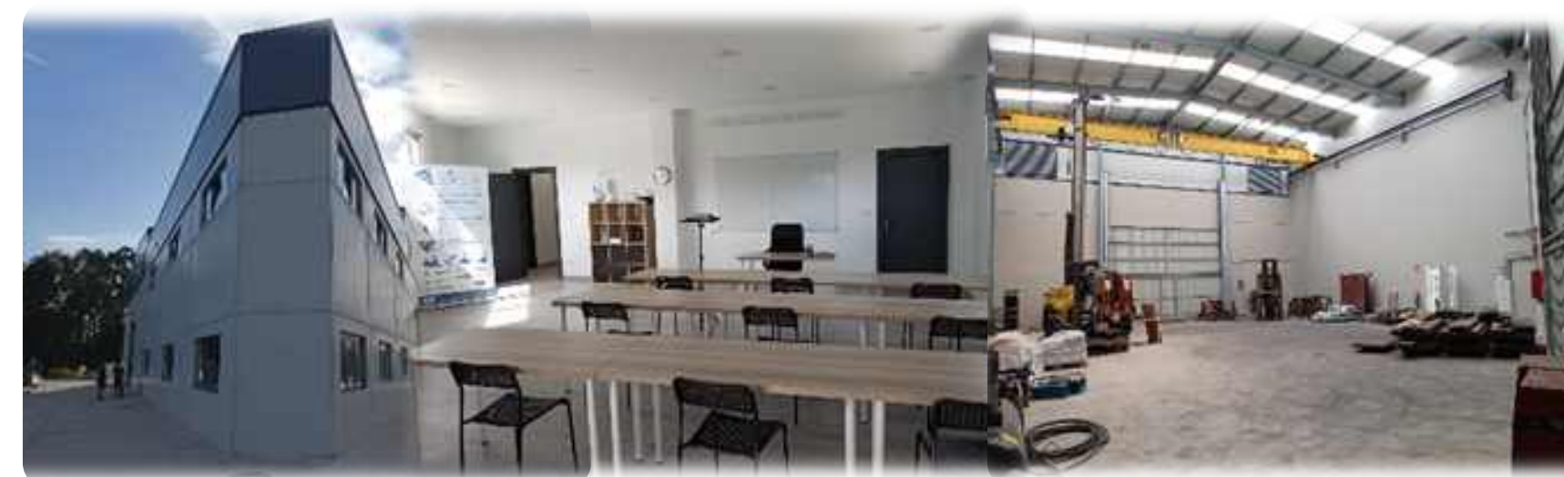
CENTRO DE SOLDADURA (Vilar do Colo)
